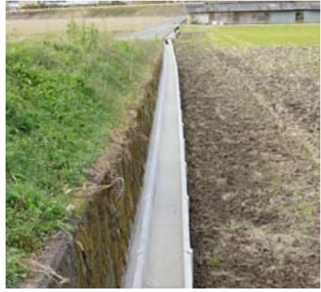
完成した大森地区の水路
