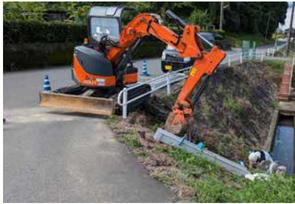
市道と連絡道の合流点で工事が開始(7月17日)
