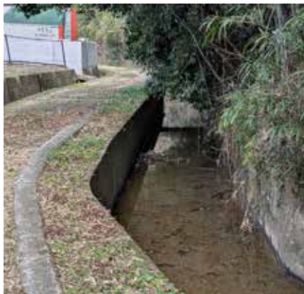
土砂の除去が終わった九田川水路
