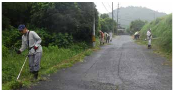
長い下り坂の両側を作業 (2班)
