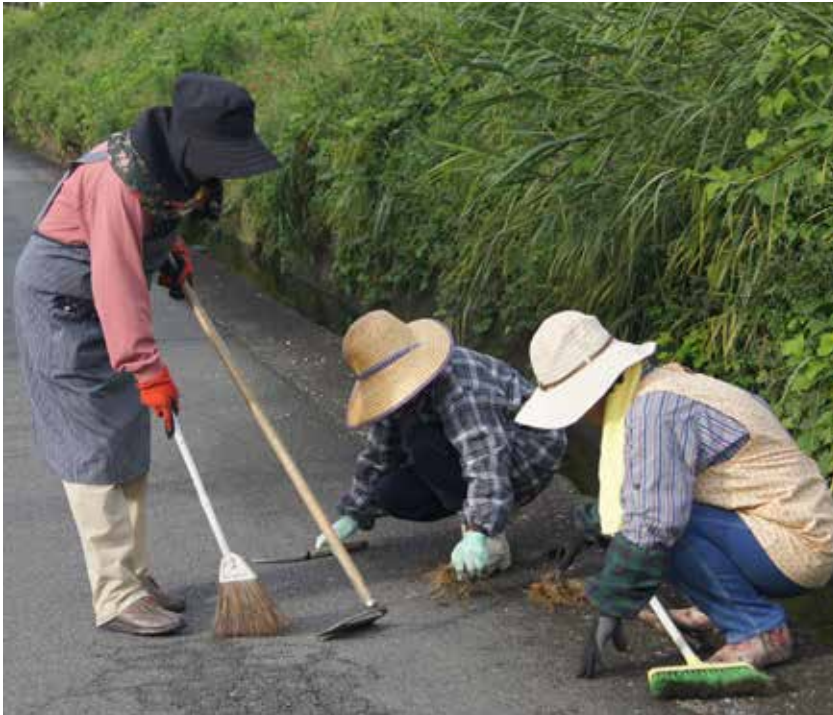
舗装の亀裂に入り込んだものも一つ一つ除去、まさに「ねつい仕事ぶり」
