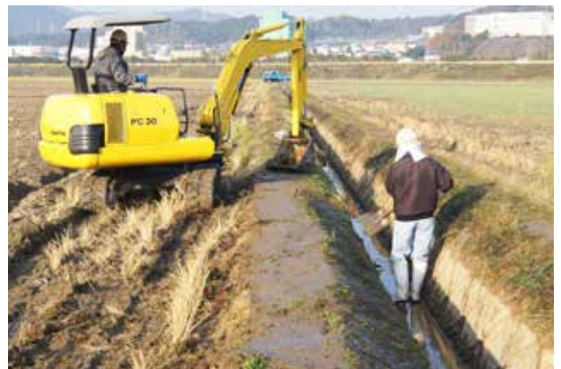
業者作業は丁寧に進捗 (平成28年12月8日)
