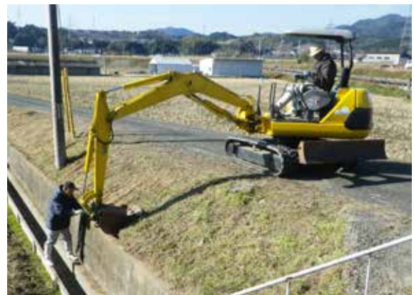
（柵亀井組さんの協力で整地作業が行われた）
