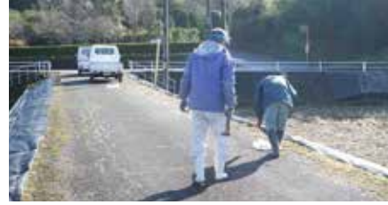
張り直しの作業中（1月28日）
