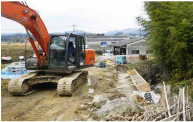
大型の建設機械が入って作業が進められている
