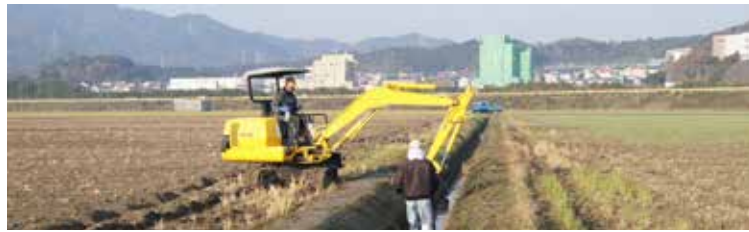
パワーショベルのバケットできれいに成型されていく(平成28年12月)
