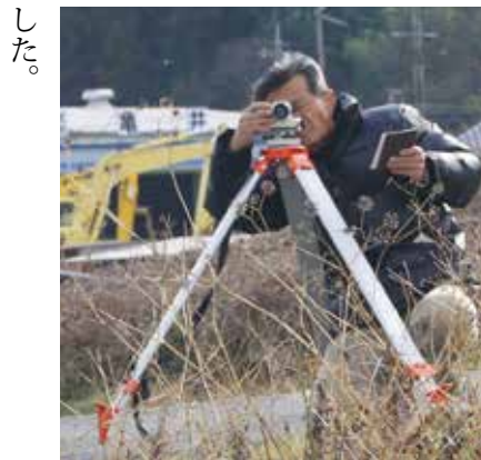
測量は経験がないとできない
