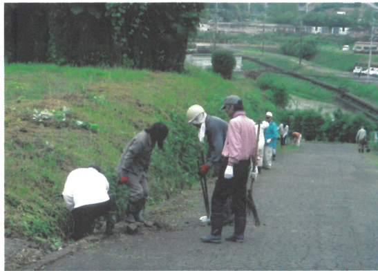
崩れてきた石垣の石を慎重に水路から除去(2班)
