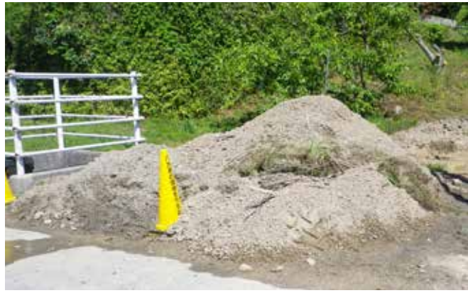
この土砂を人力で掘りあげ、運搬は厳しい（3班の近く）
