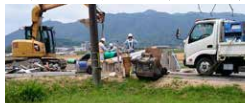
水路の場所では複雑なガス管を埋設
