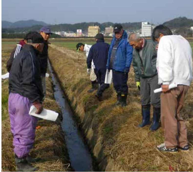
水路の現場を見て、状況を確認。工事の必要性と作業の内容を検討
