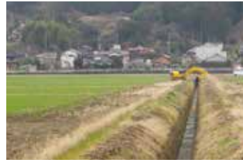
雪のちらつく中、作業は進む
