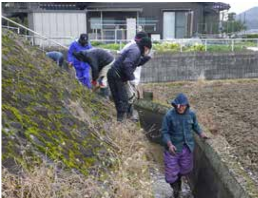
水路の中に入っての除草作業
