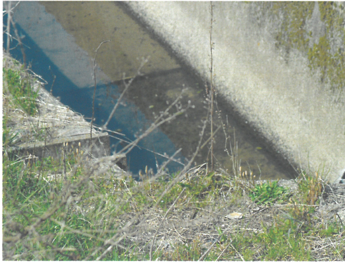
水路に降りるにもはしごか脚立の必要な大沈砂池
