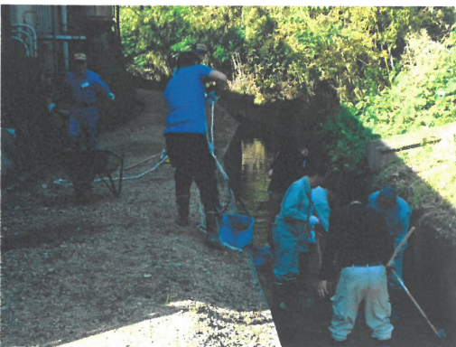
掘り上げた土砂を一輪車で運搬 (5月10日)
