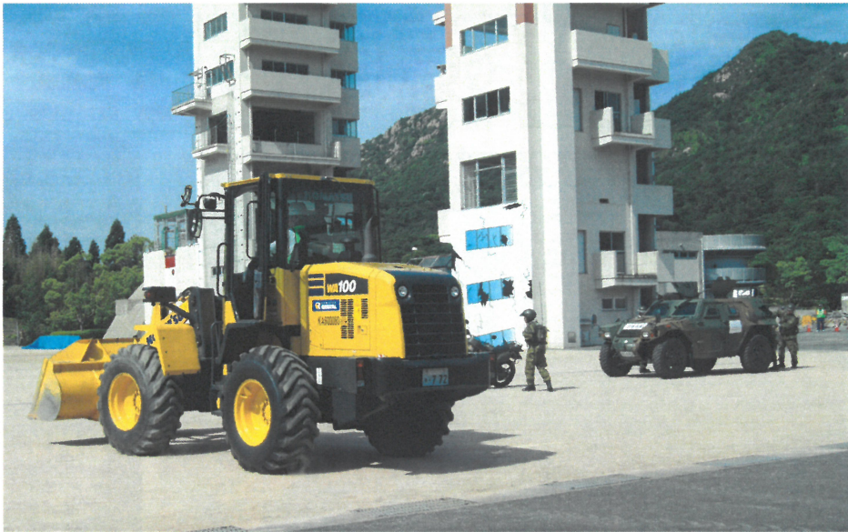
消防学校のグラウンドを使用して、大型の機械が次々に登場してくる
