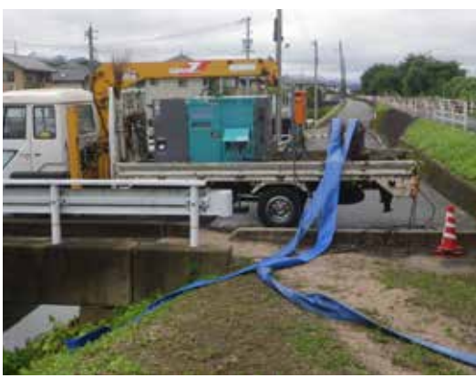
強制排水の作業の様子がうかがえる
