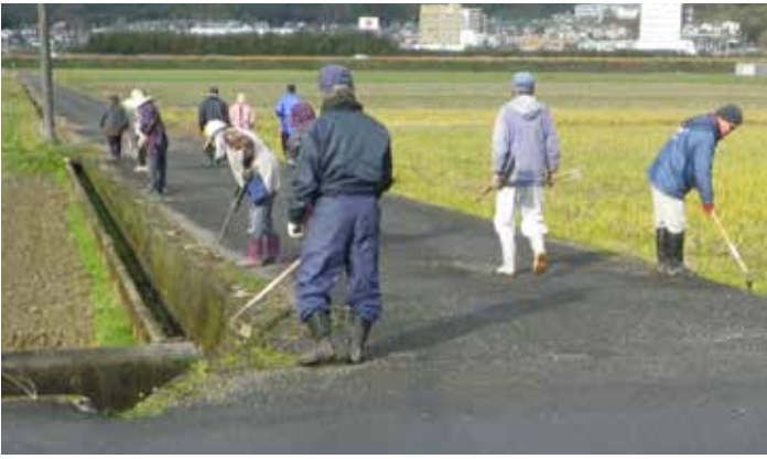
農道の路側を中心に作業を開始（平成30年12月22日）
