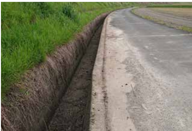
道路わきの、雑草や堆積した泥が手作業で除去
