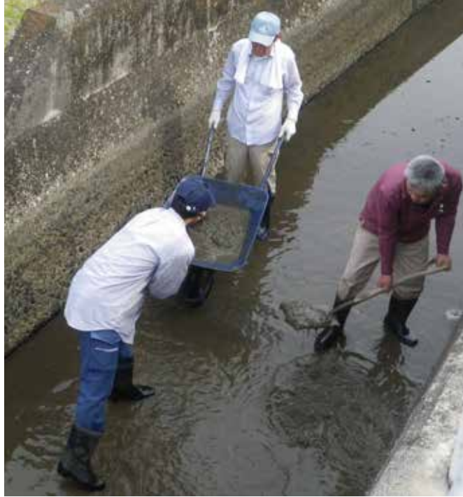
水路の中を一輪車で土砂を移動させる新方式
