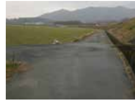
作業が済んできれいになった西側外周路
