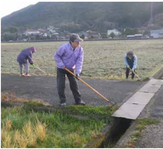
▽交差点部分や、排水路の横断部分では泥のたい積が多く作業には時間がかかる（1月13日）
