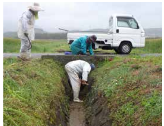
道路を横断する暗渠部分は長い鍬が必要
