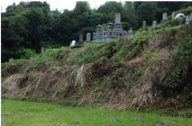
(株) 亀井組さんが作業を行われた斜面、まさに重労働
