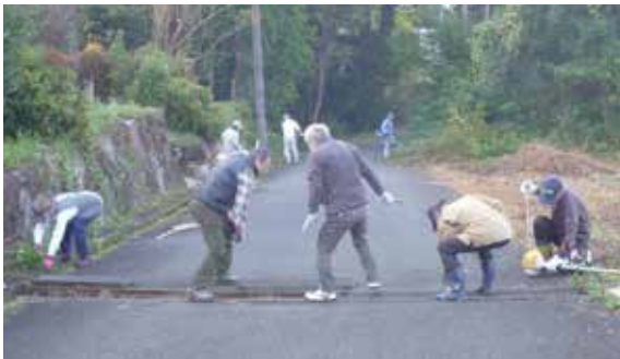
市道を横断している水路も泥上げ清掃
