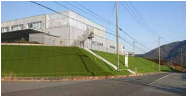
広大な法面が緑色の素材で覆われている
