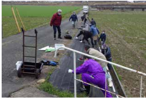
長い防草シートを取り外して、工事をスタート
