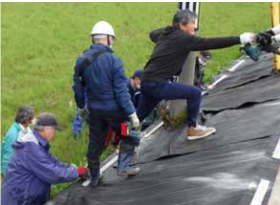
大森農道の法面に防草シートを取り付け
