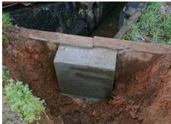
暑さ 30 cm、高さ 80 cmの補強コンクリート
