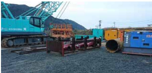
クレーンや発電機などたくさん稼働中
