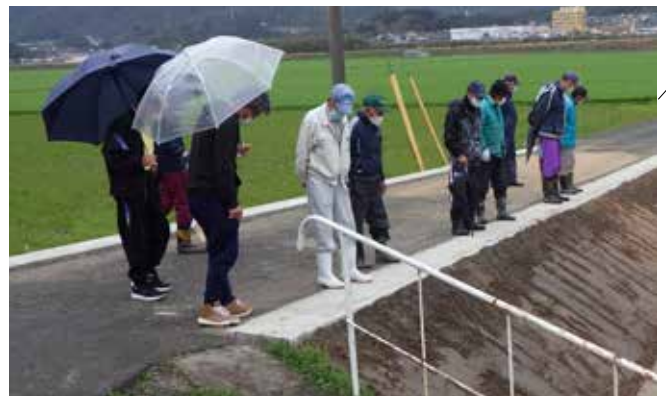
完成した擁壁と新たな縁がかりを検査 (3月20日)
