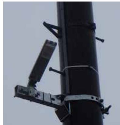
新しいタイプの防犯灯が設置
