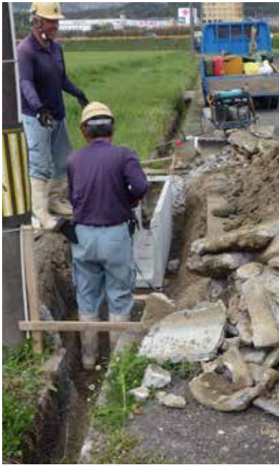
▲大きく掘り下げて高さの調整
