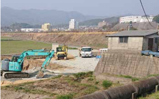
掘削した土砂が隣の農地に一時的に保管されている
