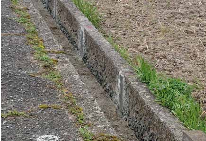
上流側（東側）を優先的にして 80 カ所の補修箇所を選んだ
