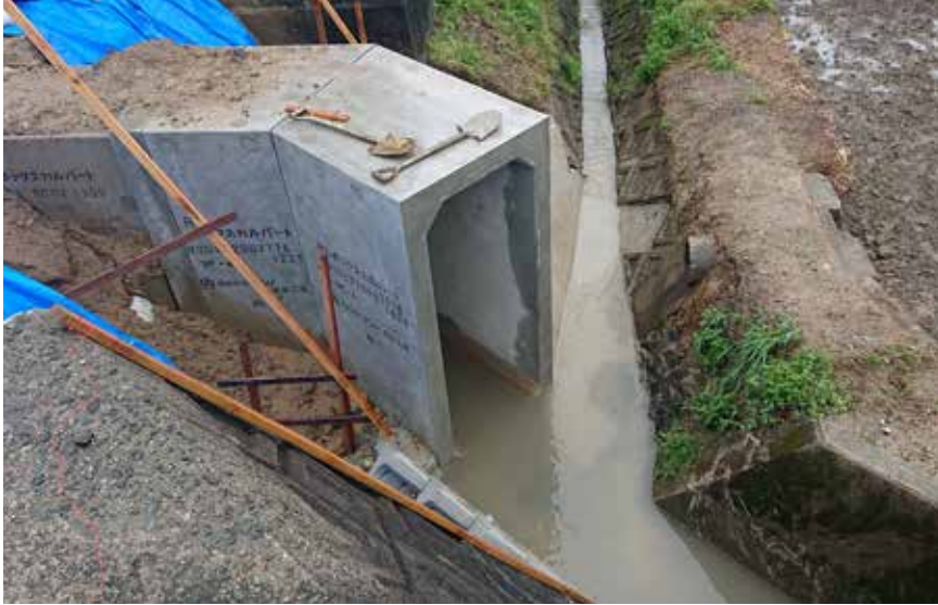
水路が屈折しているためにコンクリート製品の出来上がりが遅れた
