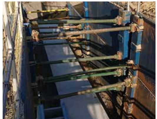
がっちりと保持された水路工場の現場
