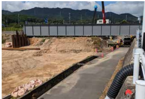
大幅に長くなった鉄橋が設置され、これから掘削工事
