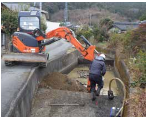
重機のみでみるみる土砂は取り除かれる
