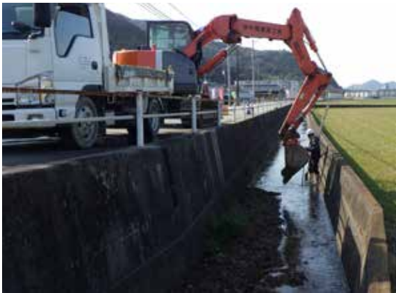
土砂お除去とともにその処理も重要
