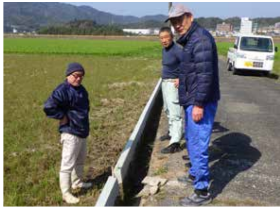
工事の状況を確認（3月16日）
