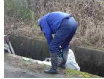
▶ハンマードリルでコンクリートに穿孔 ◀取り付けられた昇降ステップ
