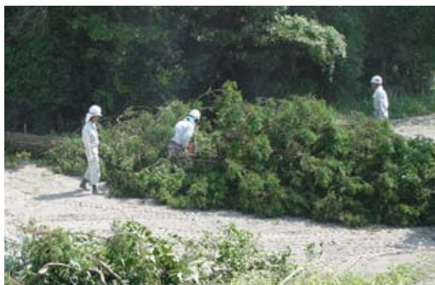
一本のワイヤーは100メートル以上離れたところの樹木から、もう一本は小型建設機械につないで倒す方向を決めてある
