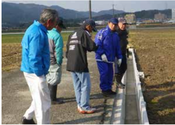
工事の終わった個所を確認する
