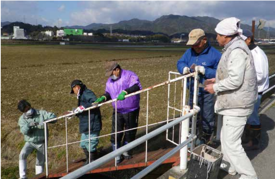
塗装の前に傷んだ塗料やさびなどを除去します。これがなかなか大変。
