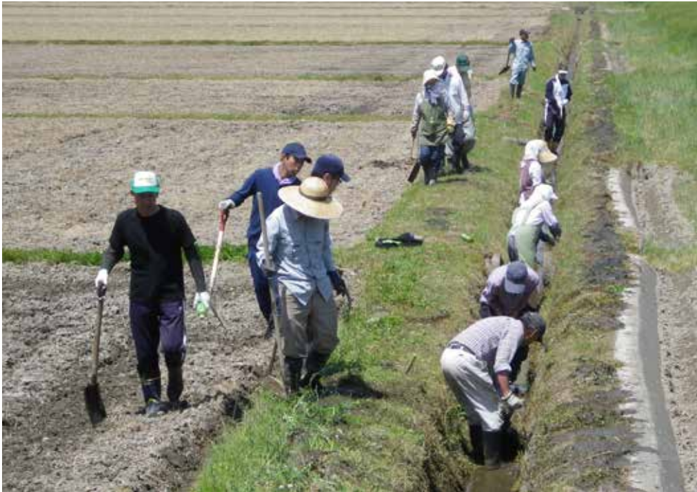
水路の泥上げは下流への土砂流出を防ぐことになる（平成25年5月12日）
