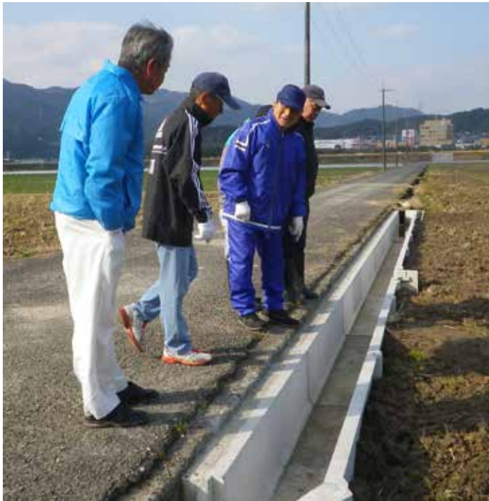
完成した西の池水路改修の確認をする役員(平成25年12月)
