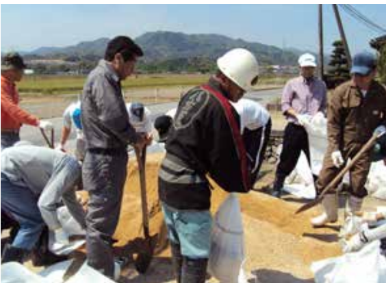
110個の土のうを詰めて、危険個所に配置
