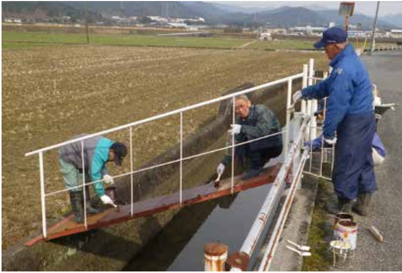
手すりと踏み板部分をしっかり塗装（1月25日）
