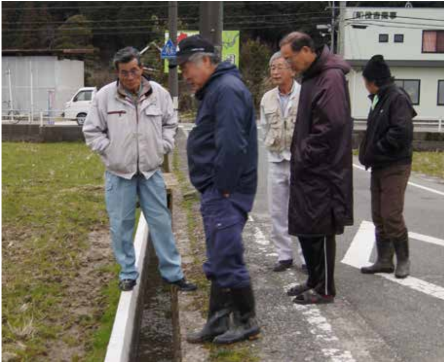
工事関係者と八方原の環境を守る会とで工事の完成状況を確認
