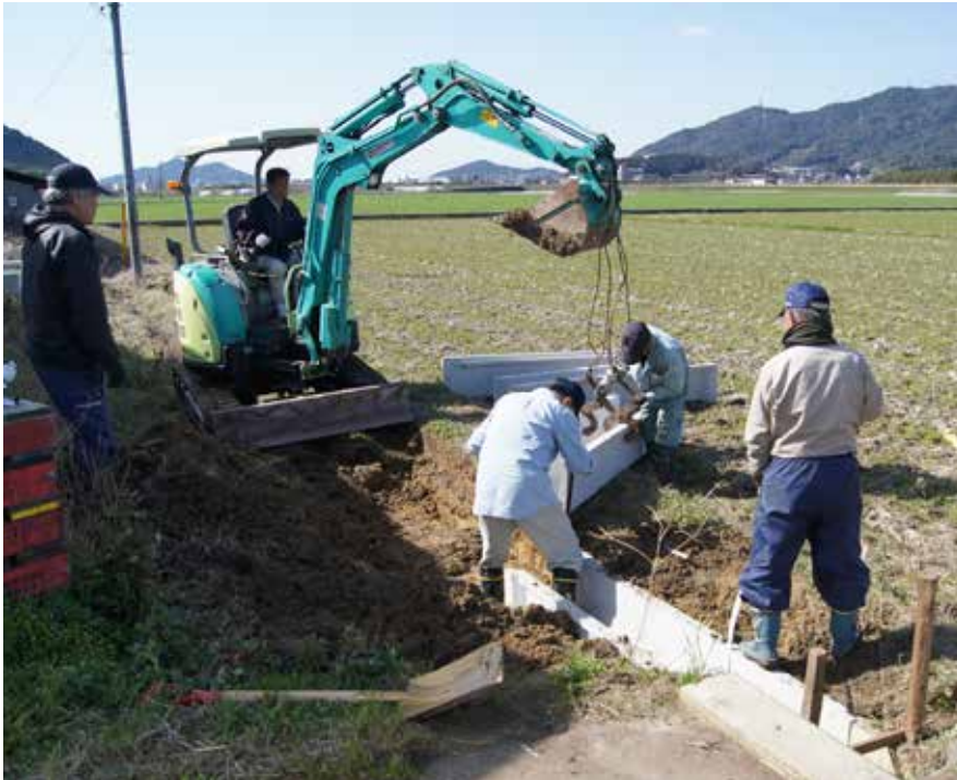
ショベルで掘る役、吊り上げの準備をするもの、高さを見るもの、全員参加
