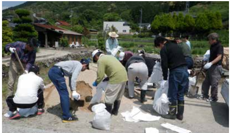
本田消防組頭の指示通り、防災用に確保した真砂土を土嚢に詰める。
