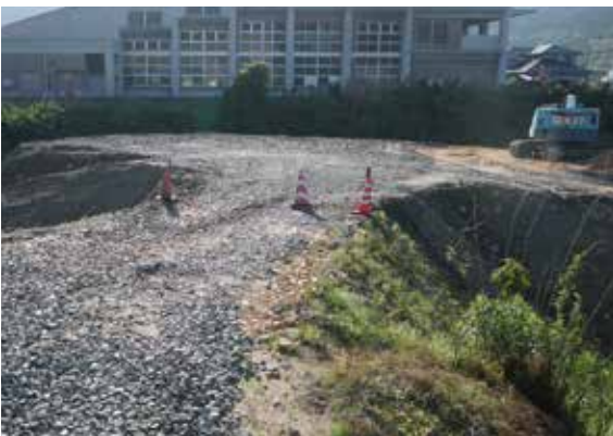
作業が始まった道路建設箇所、奥は給食センター
